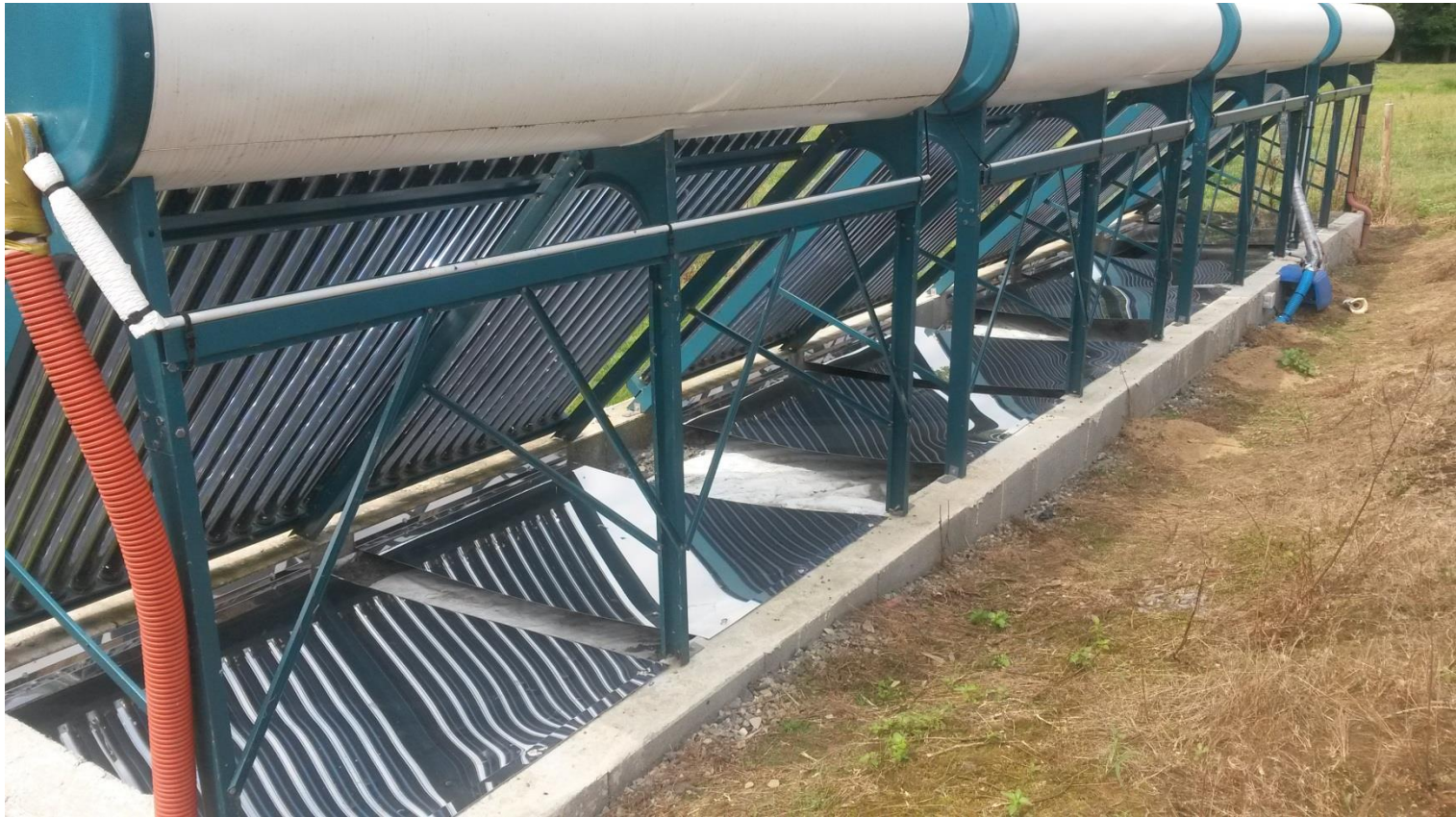
Miroir en inox installé le 1er aout 2014
