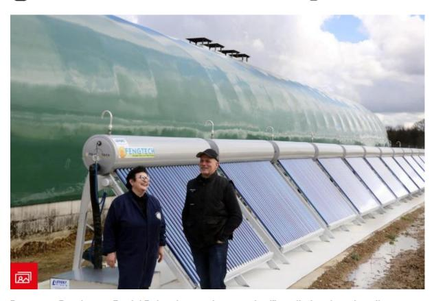
Panneaux. Roselyne et Daniel Delongle ont mis en service l'installation thermique il y a un an. 510 tubes sous vide captent l'énergie solaire. Le système stocke 5 m © Photos : V. Gobert
