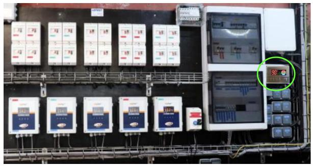
Contrôle. L'écran du système avec suivi des températures (cercle vert) est placé à droite des cinq écrans de contrôle d'ambiance.
